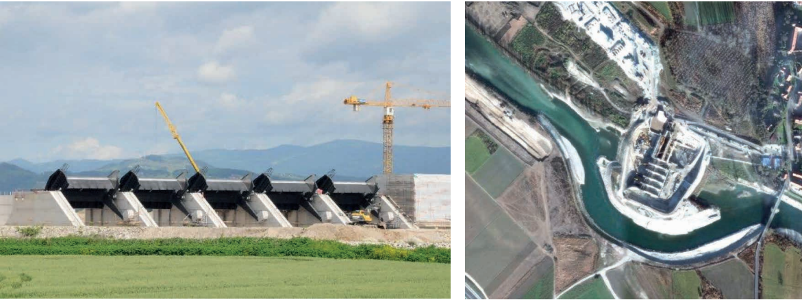
□ Slike 45 i 46: Gradilište hidroelektrane Brežice 2015. g. (lijevo © Ulrich Schwarz, desno [21]).
