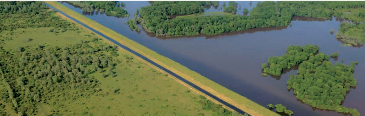
□ Slika 63: 77 % aktivne poplavne nizine izgubljeno je iza nasipa za obranu od poplava izgrađenih vrlo blizu rijeke Save (© Goran Šafarek).
