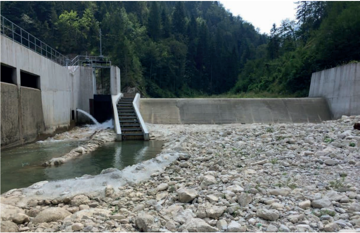
□ Slika 47: HE Novakovići koju je izgradio KELAG na rijeci Ugar u BIH, u kojoj je nekad živjela mladica. Riblja staza nije odgovarajuća i rezidualni tok nizvodno od brane, tanak mlaz u koritu rijeke, nije dovoljan (© Ulrich Eichelmann).
